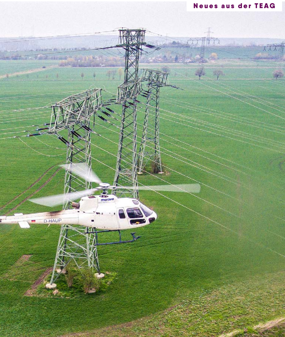
Beim Abfliegen der 110-kV-Trassen nähert sich der Helikopter den Leitungen bis auf fünf Meter an.
