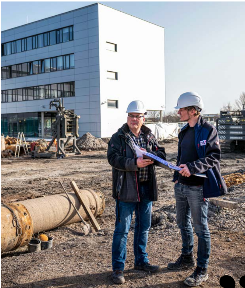
Sascha Dörnfeld spricht mit Bauleiter Andreas Stöbel über das Fundament von „Modul 3“ des TEAG-Campus.
